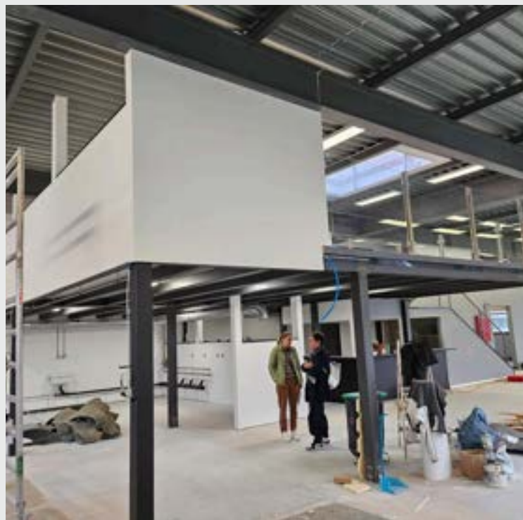
Déménagement des ateliers Blanchisserie et Informatique à Yverdon-les-Bains
